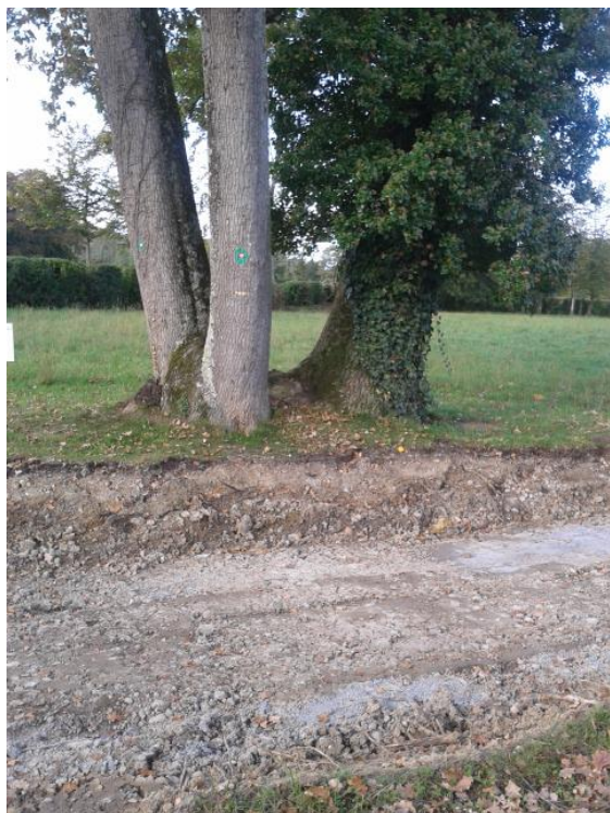
Rectification des pentes sur la voie carrossable existante
