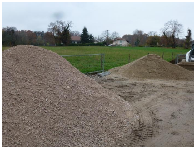
Sable du Salève (matériau local)
