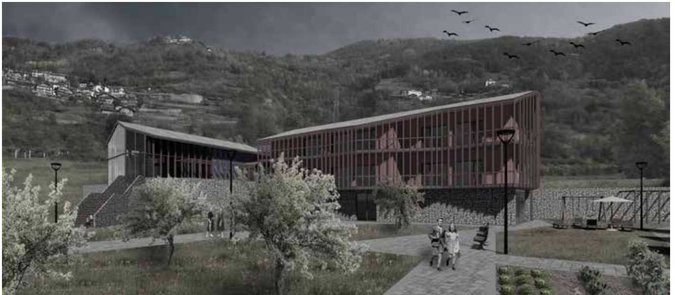
Foto 16 - La Salle 1 - Il progetto ha previsto la parziale demolizione della colonia esistente e la giustapposizione di una doppia pelle sulla porzione rimanente, donando all'edificio uno spiccato carattere contemporaneo. Studenti: Luca Cina, Daniel Diemoz, Giulia Fiocca, Ilaria Genzano
